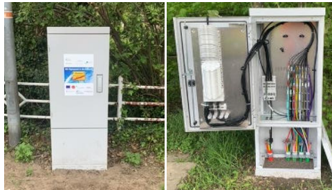
RVT/NVT (28 + 1 Bestands NVT) In Ausnahmefällen: Schacht + Muffe
