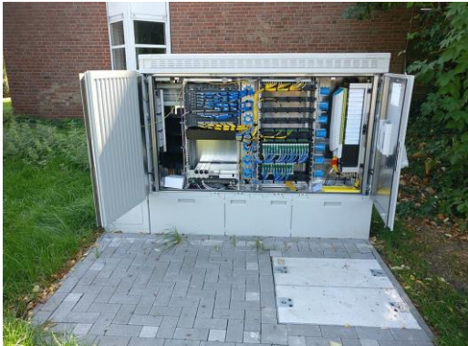
RVT/NVT (28 + 1 Bestands NVT) In Ausnahmefällen: Schacht + Muffe
